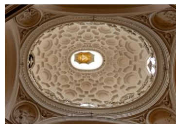
F. Borromini, cupola ellittica della chiesa di S. Carlo alle Quattro Fontane, Roma
